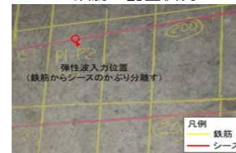
鉄筋の配置状況
